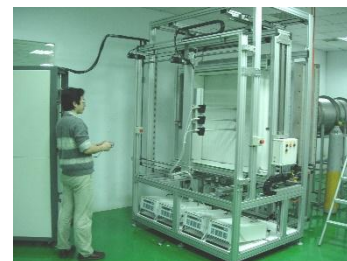
HEPA 过滤器泄漏扫描
